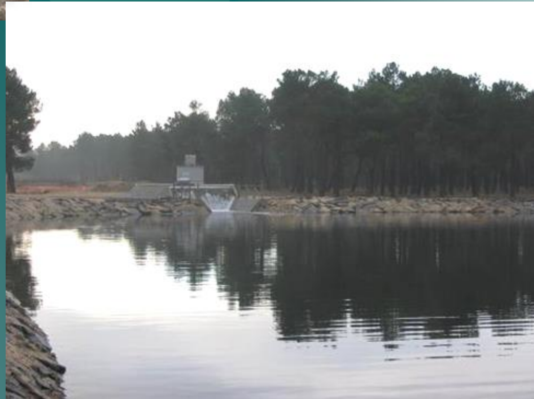
BALSA DE INFILTRACIÓN SANTIUSTE (SEGOVIA)
