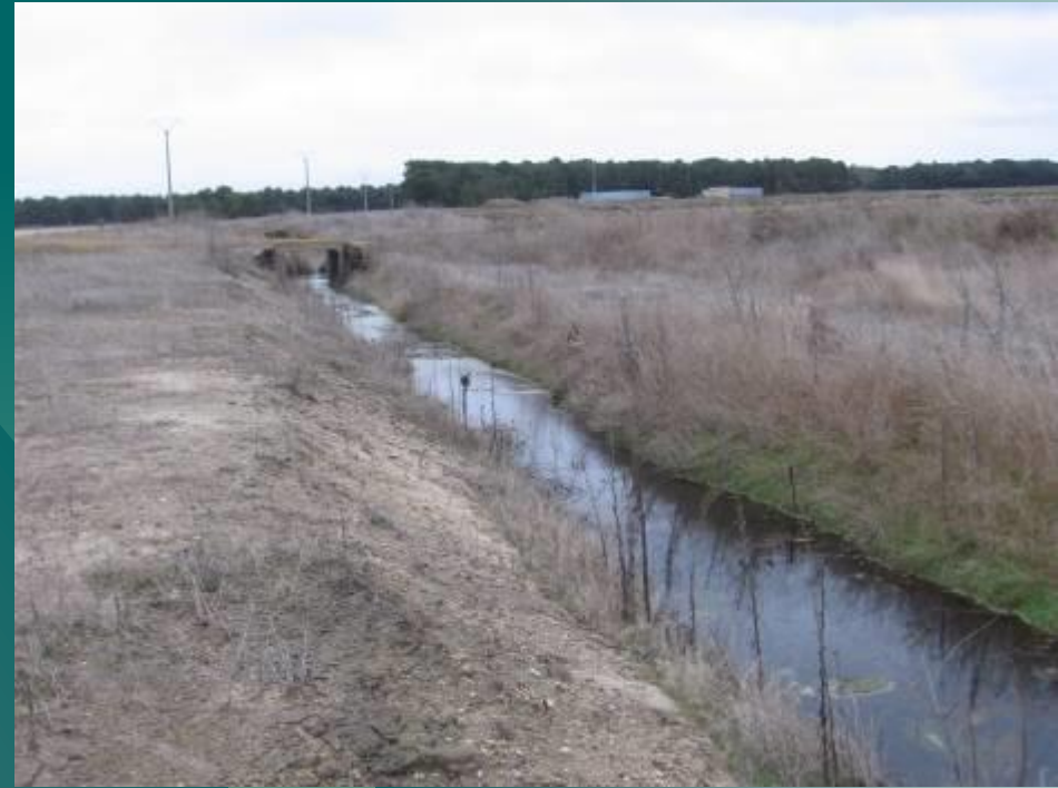
CANAL DE INFILTRACIÓN CARRACILLO (NARROS DE CUÉLLAR)
